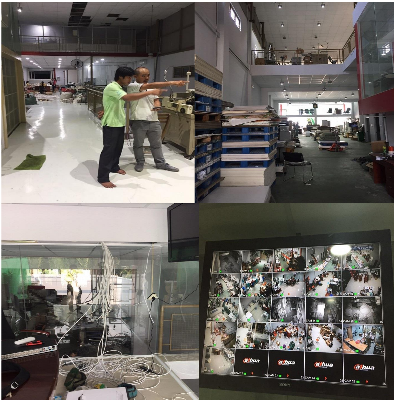
10. CTY VIỆT MỸ LẮP ĐẶT HỆ THỐNG CAMERA CHO CTY DKVINA TẠI BÌNH DƯƠNG
